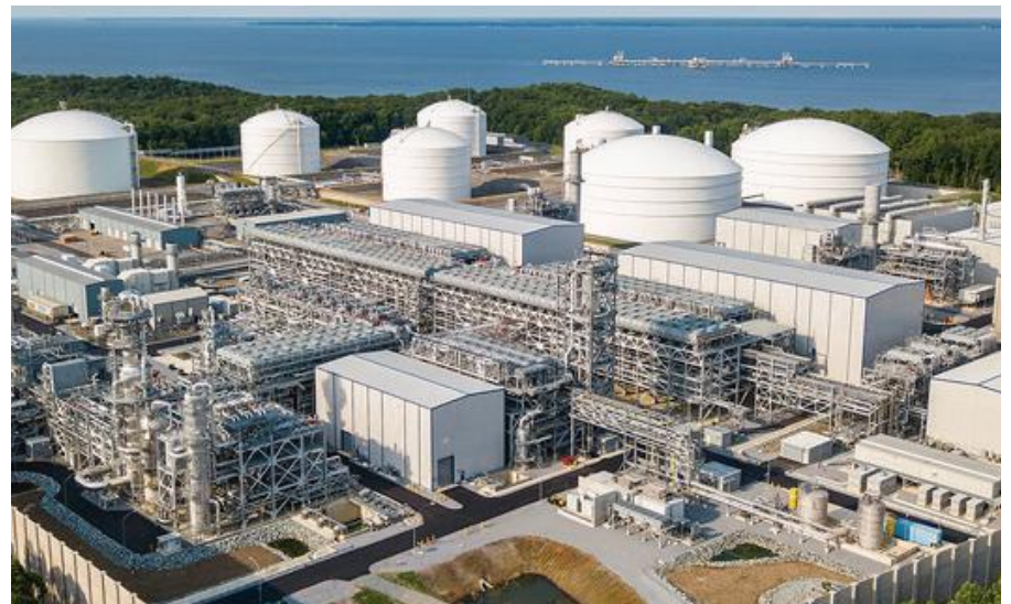
Dominion Cove Point LNG plant
